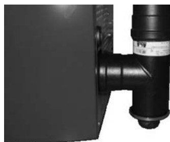
Rys. 83 - Czyszczenie kanału dymowego
