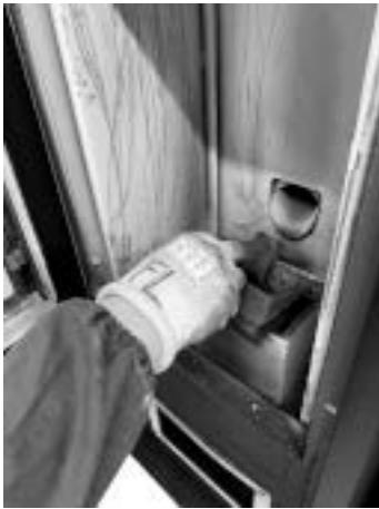
Rys. 78 - Wyjmowanie paleniska
