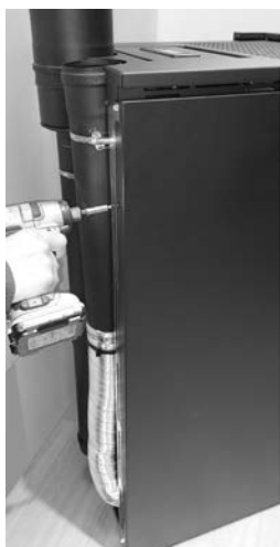
Rys. 21 - Odkręć tylne śruby
