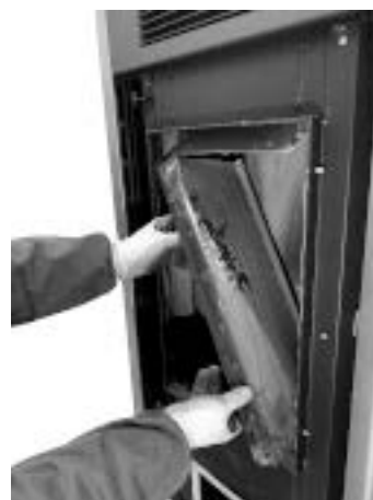
. 88 - Demontaż ścian bocznych
