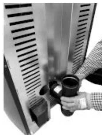
. 51 - Zdejmij zaślepkę Rys. 52 - Zdejmij zaślepkę Rys. 53 - Podłącz trójnik
