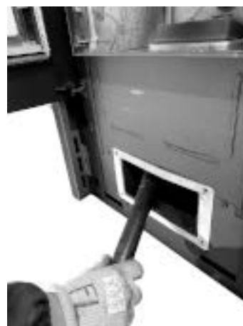
. 89 - Czyszczenie za pomocą wyciora do rur Rys. 90 - Odkurzanie popiołu
