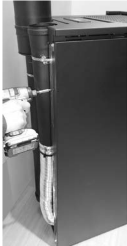
Rys. 31 - Odkręć tylne śruby
